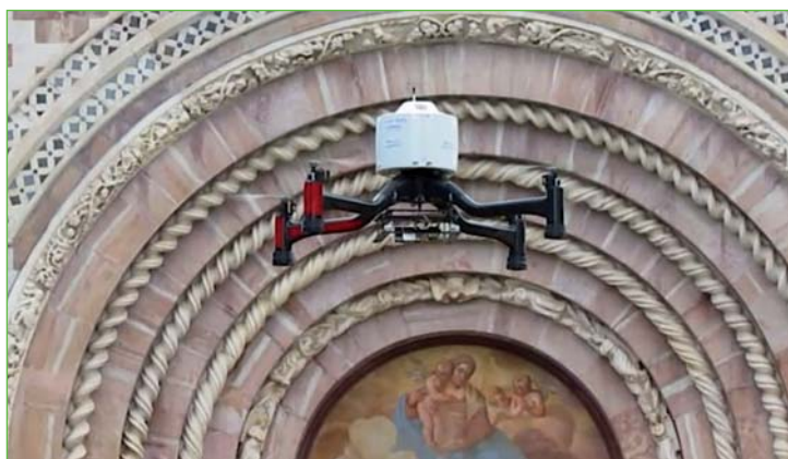
Figure 5 : Le drone Anteos Mini en cours d'acquisition.
