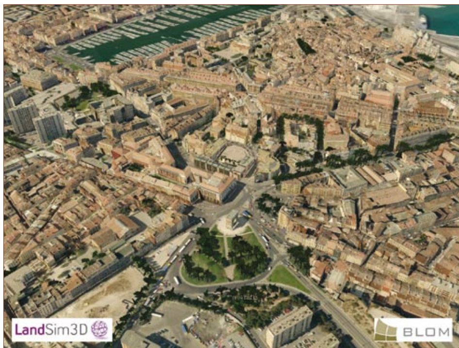
Bionatics a signé un partenariat avec Blom afin d'intégrer dans LandSim3D les orthophotographies de l'avionneur norvégien et ses modèles de ville dérivés.
