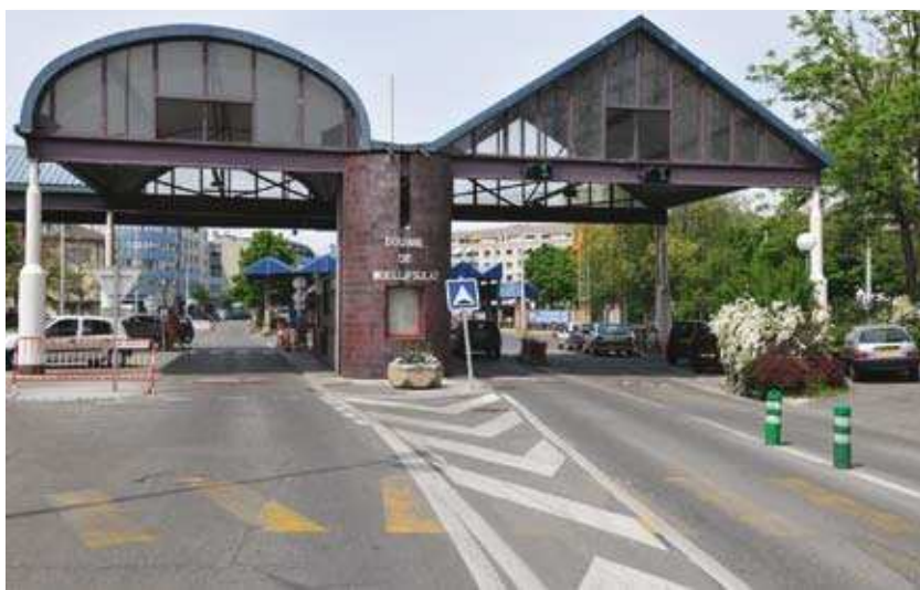
La douane de Moellesullaz (notez l'orthographe suisse : Moillesullaz) sépare Gaillard de Chêne-Bourg. Ces constructions modernes représentent à peu près tout ce que les frontaliers connaissent de la limite franco-suisse.
