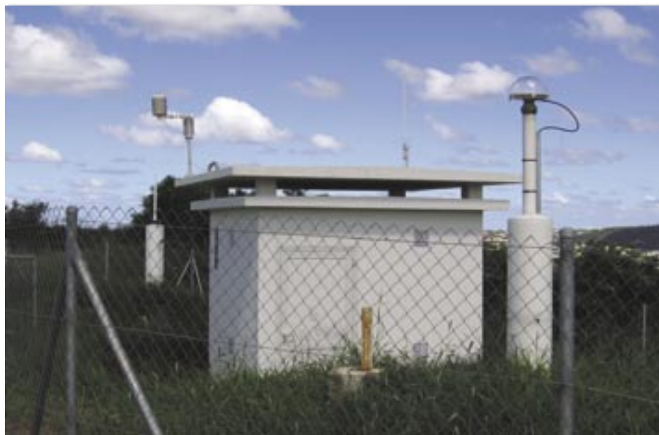
La station permanente NRMD, seconde station de Nouméa, est installée sur une colline appartenant à l'armée.
