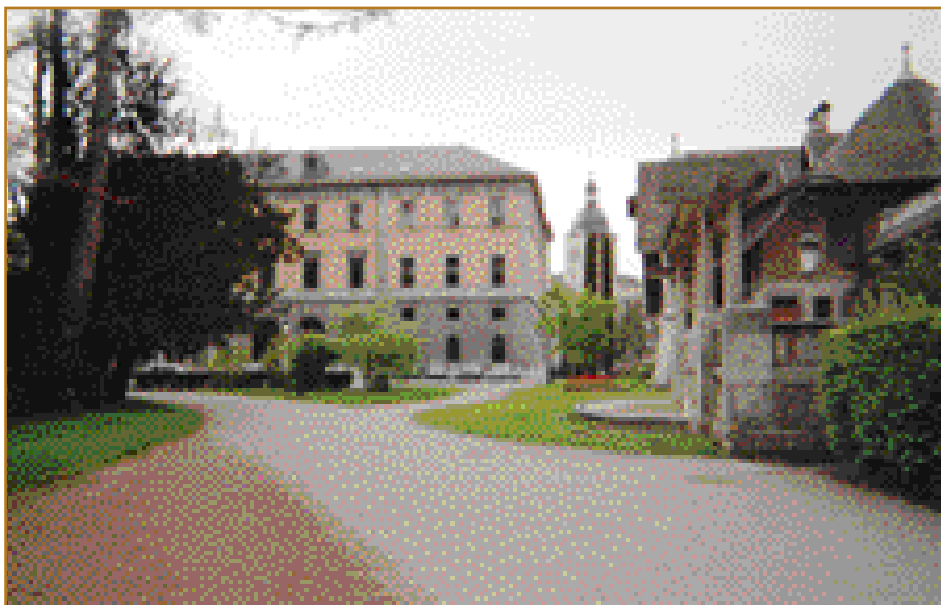
La préfecture de la Haute-Savoie mêle espaces verts, bâtiments historiques et environnement lacustre.
